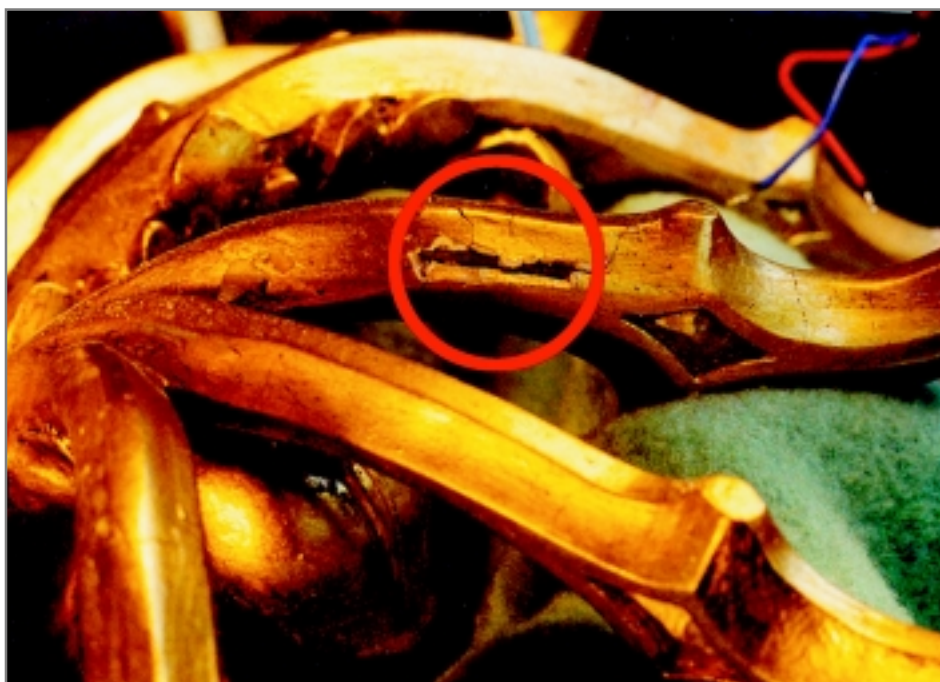
Slika 30: Vzdolž svečnikov so bili izkopani žlebovi, v katere so bili položeni električni vodniki. Žlebovi so bili potem zakitani in prekriti z lističi iz valjane medenine.
