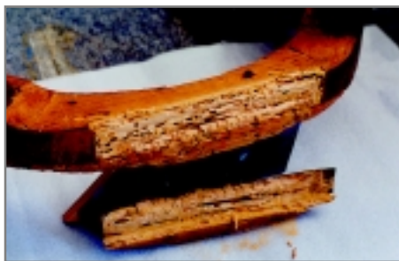
Slika 3: Les, poškodovan od lesnih insektov
